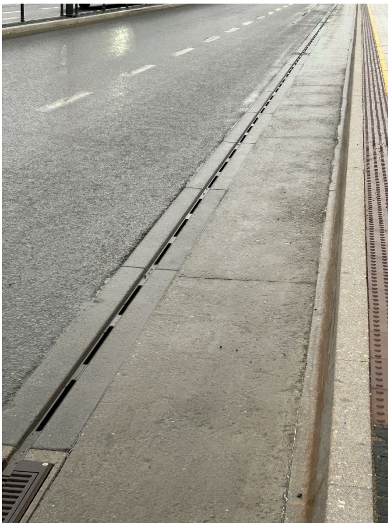
Figur 5.2-2: Eksempel på løsning med slisserenner langs med holdeplass. Bildet er tatt ved bussholdeplassen på Trondheim sentralbanestasjon.
