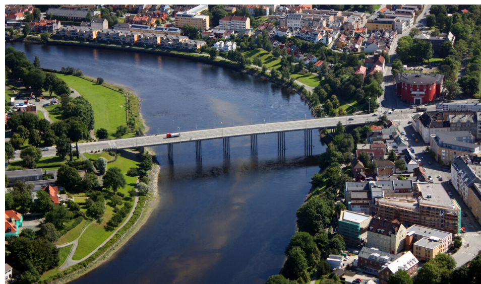
Figur 2-2: Elgeseter bru ligger tilknyttet planområdet og er fredet. (Foto: Trondheim havn)
