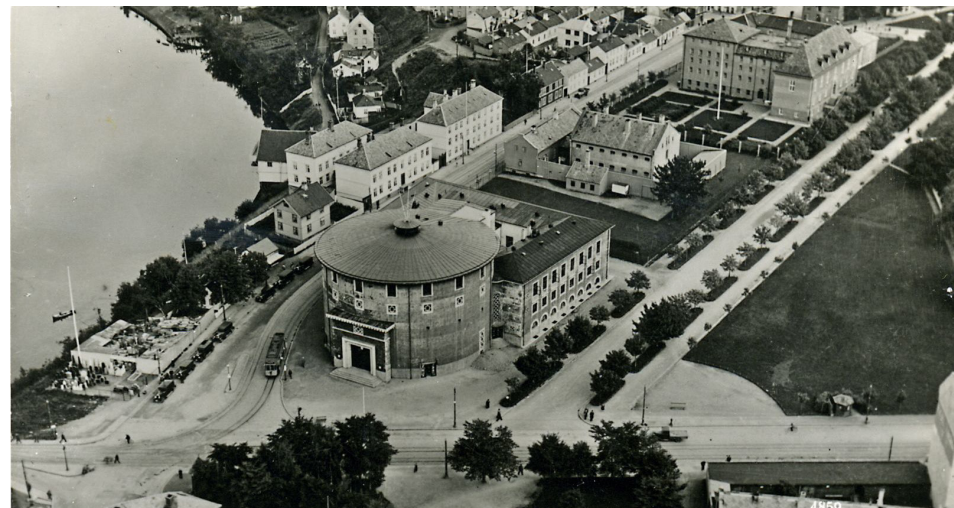
Figur 8-2: Postkort fra ca. 1930 viser Studentersamfundet, Høgskoleveien og Elgeseter Park. Parken er avrundet ved hjørnet som i plan fra 1927. Kilde: Strinda historielag
