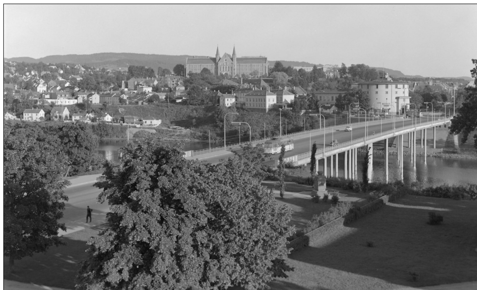
Figur 5-8: Elgeseter bru, med Studentersamfundet og Gløshaugen (NTH) i bakgrunnen, 1960. Kilde: Trøndelag folkemuseum.
