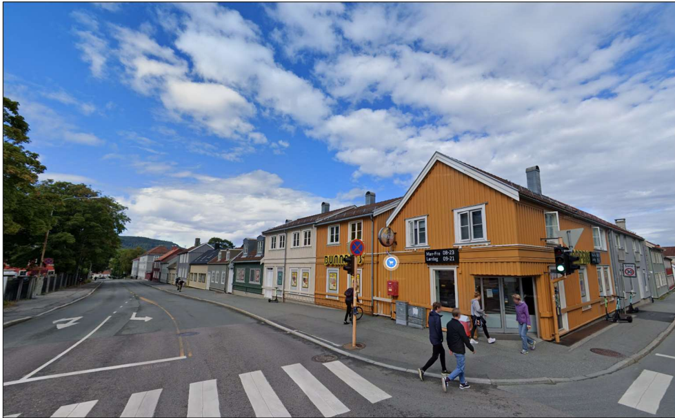
Figur 6-20: Klostergata i retning vest, med trehus fra 1800-tallet på Jonsløyken. Kilde: Google.
