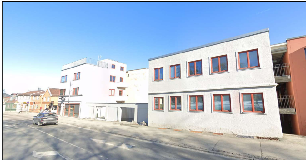
Figur 6-19: Singsakerbakken 2 med funksjoninspirert bebyggelse, i retning nordvest. Kilde: Google.
