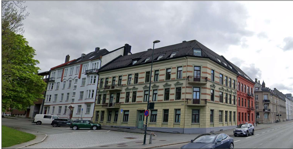
Figur 6-16: Elgeseter gate 9 og 11, sett i retning sørøst. Kilde: Google.
