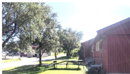
Figur 5 Eksisterende bebyggelse på tomten er oppført med to etasjer inkludert sokkel, og saltak.
