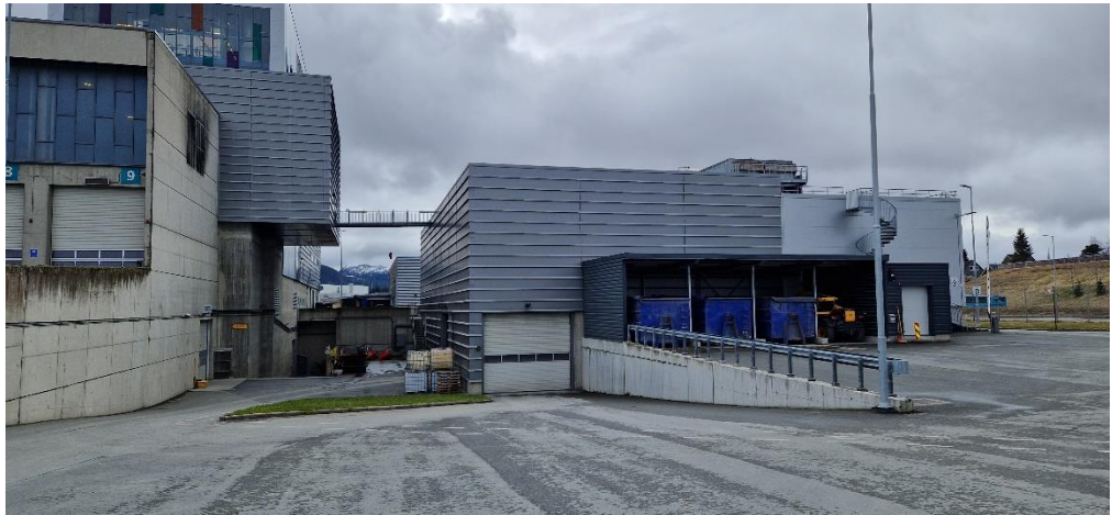
Figur 6-9: Det eksisterende forbrenningsanlegget til Statkraft.
