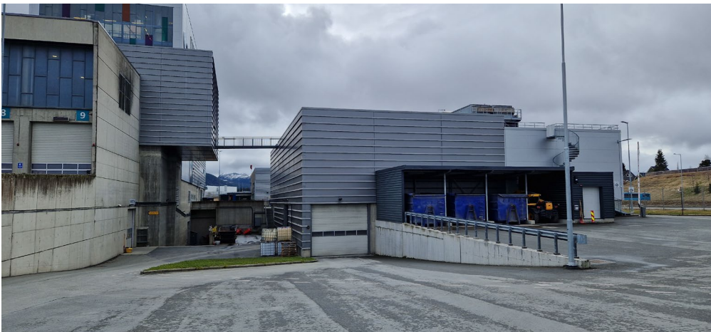
Bilde 2: Det eksisterende fjernvarmeanlegget til Statkraft
