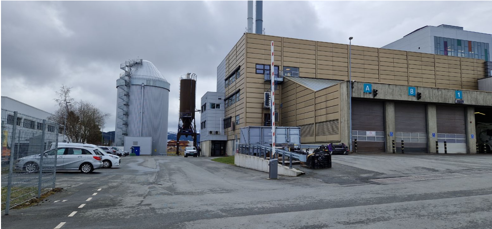
Bilde 1: Det eksisterende fjernvarmeanlegget til Statkraft
