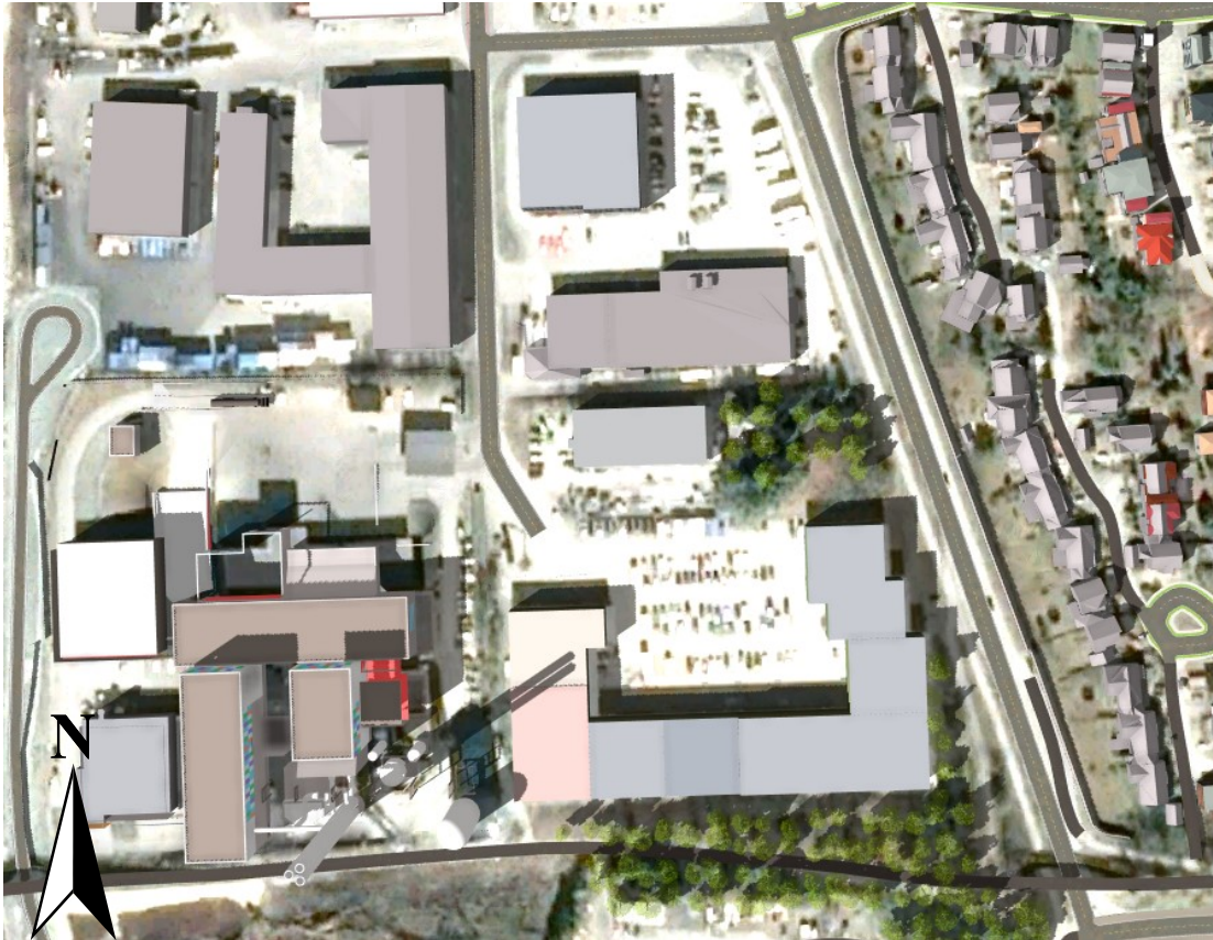
Eksisterende situasjon 20. juni kl. 16.00
