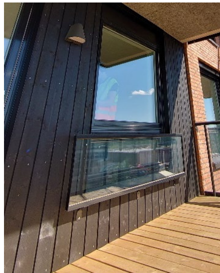
Figur 10 - Nærbilde av lokal skjerm foran fasade.
