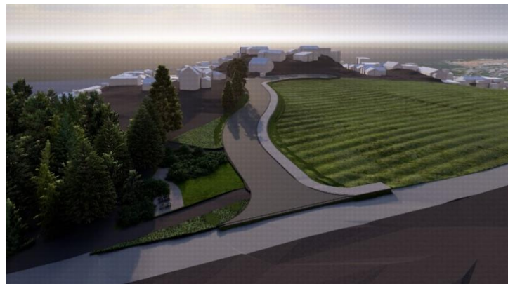
Figur 20 Nytt T-kryss mellom Saksvikkorsen og Væresvegen/Markabygdvegen- Gang- og sykkelvegen forlenges fram til kryssing over Saksvikkorsen, og det tilrettelegges for kryssing over fylkesvegen.
