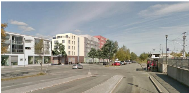
Figur 25 Fjernvirkning, fra Heimdal stasjon.
