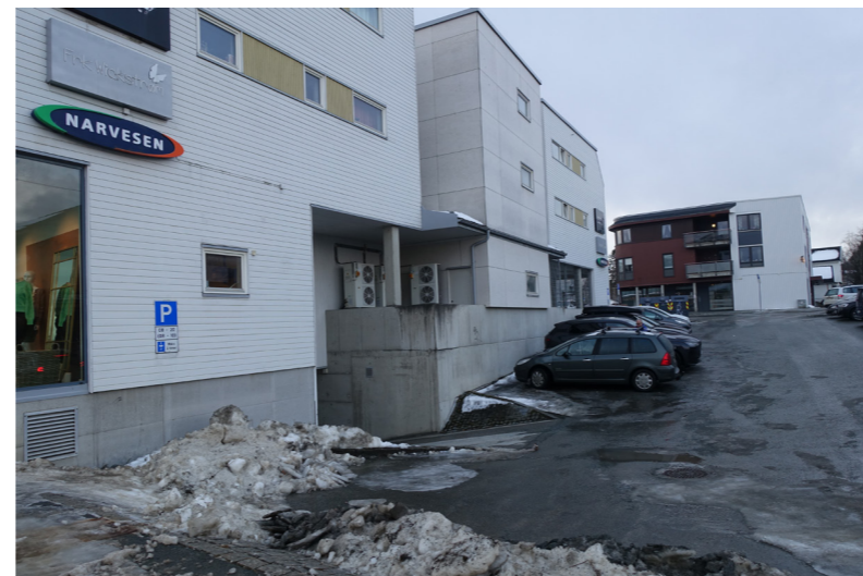
Parkeringsplassen sør for planområdet. Bygget sør for planområdet har en del tekniske anlegg på fasaden og innkjøring i kjeller via parkeringsplassen. Terrenget på parkeringsplassen faller fra vest mot øst.
