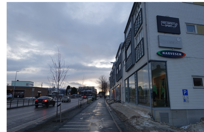
Langs vegen Bjørndalen, sett mot sør. Heimdal stasjon på venstre side av vegen. Bebyggelse langs den nylig etablerte gang- og sykkelvegen har sin fasade kant i kant med fortauet, som medfører at fortauet brukes til snøopplag.
