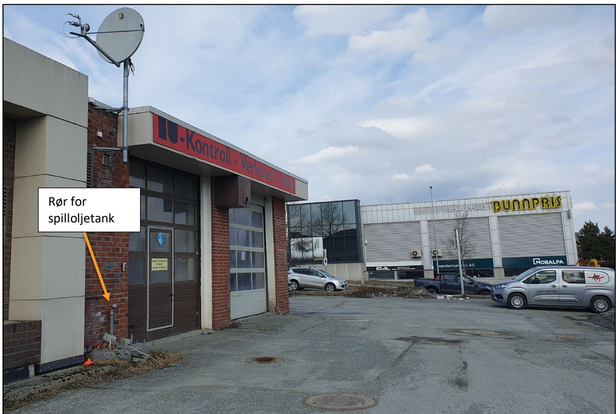
Figur 19: Nordøstre del av bensinstasjonsbygningen i Søbstadvegen 5. Rør for spilloljetanken er plassert ved portene til verksted og vaskehall. Foto: Multiconsult.
