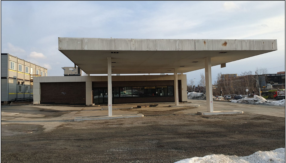
Figur 18: Bilde av bensinstasjonsbygningen i Søbstadvegen 5, sett fra sør. Til venstre i bildet er brakkeriggen anvist. I nedre del av bildet er området for tidligere utført sanering av hovedtankgrop. Foto: Multiconsult.
