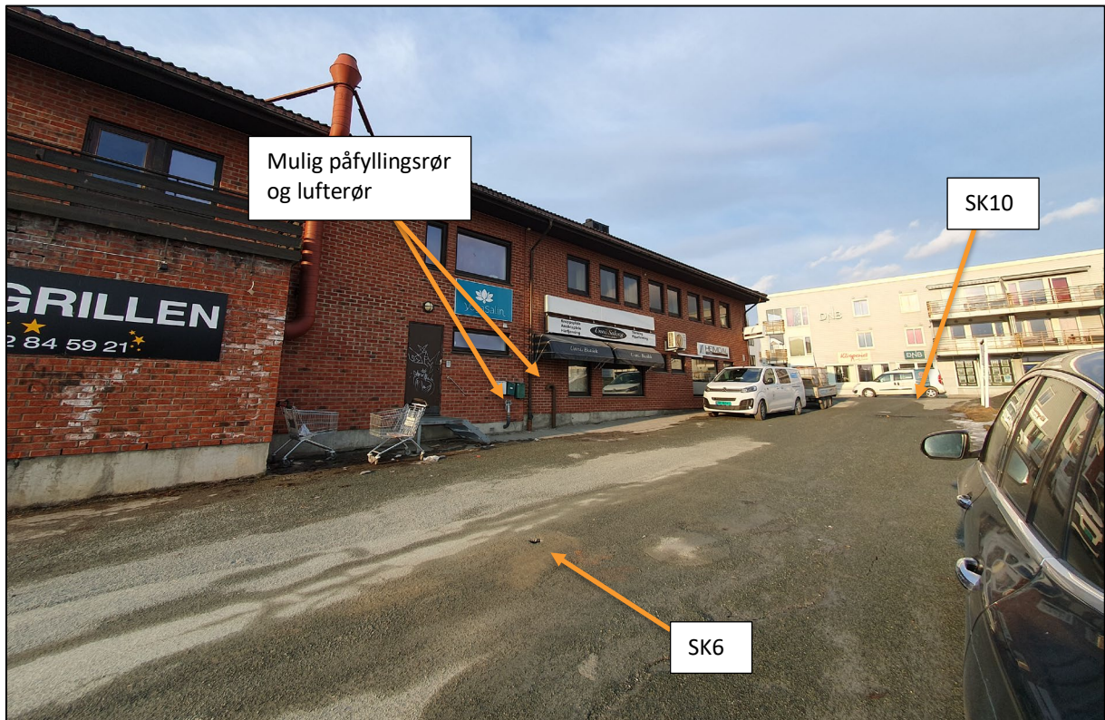
Figur 22: Nordveggen av Søbstadvegen 3, med angivelse av borpunkt SK6 og SK10. Mulig lufterør og påfyllingsrør på veggen er vist. Foto: Multiconsult.
