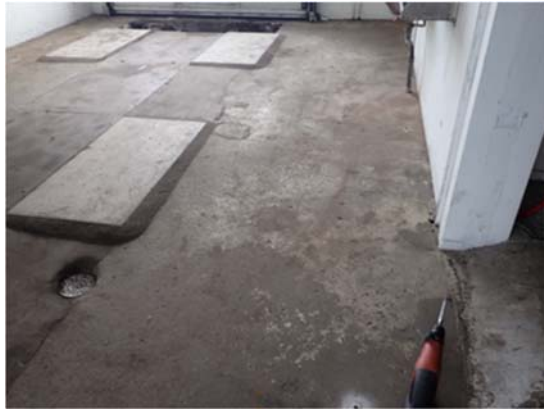
Figur 12 Gråmalt betonggulv i smørehall, prøve B10.
