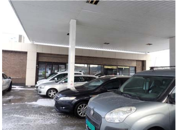
Figur 4 Fasade mot sør.
