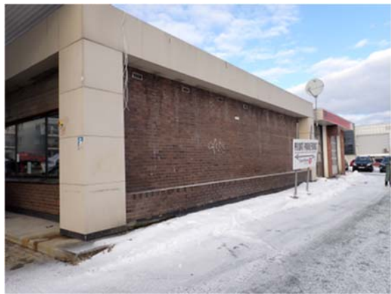
Figur 6 Fasade mot øst.
