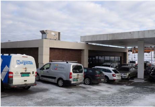
Figur 3 Fasade mot sørvest.
