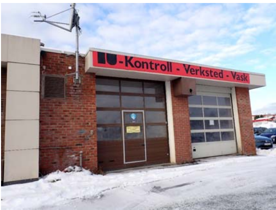
Figur 5 Fasade mot øst.
