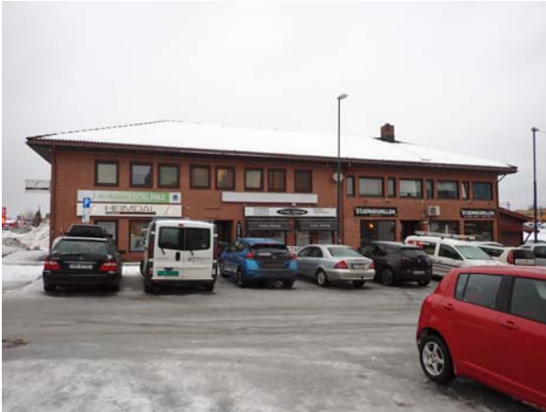
Figur 3 Fasade mot sør.
