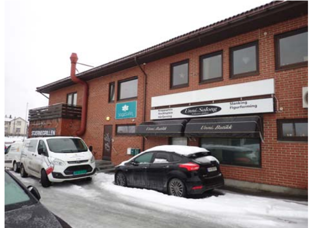
Figur 4 Fasade mot nord.
