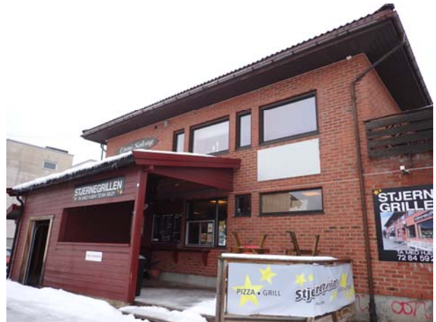
Figur 6 Fasade mot øst.
