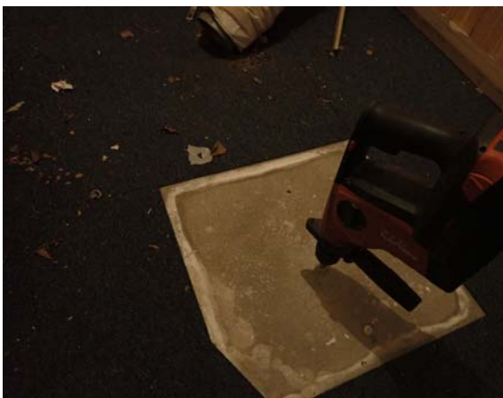
Figur 15 Prøve av betonggulv i kjeller i eldste del (K9).
