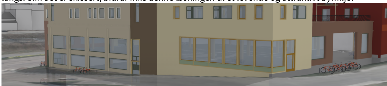
Figur 16 Fasade mot Søbstadvegen i nord. Første etasje består i hovedsak av parkeringsareal.
