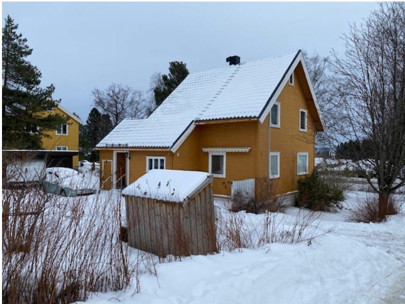
Holtveien 1 fra sørvest
