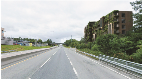
Støyskjermende boligbebyggelse sett fra E6
