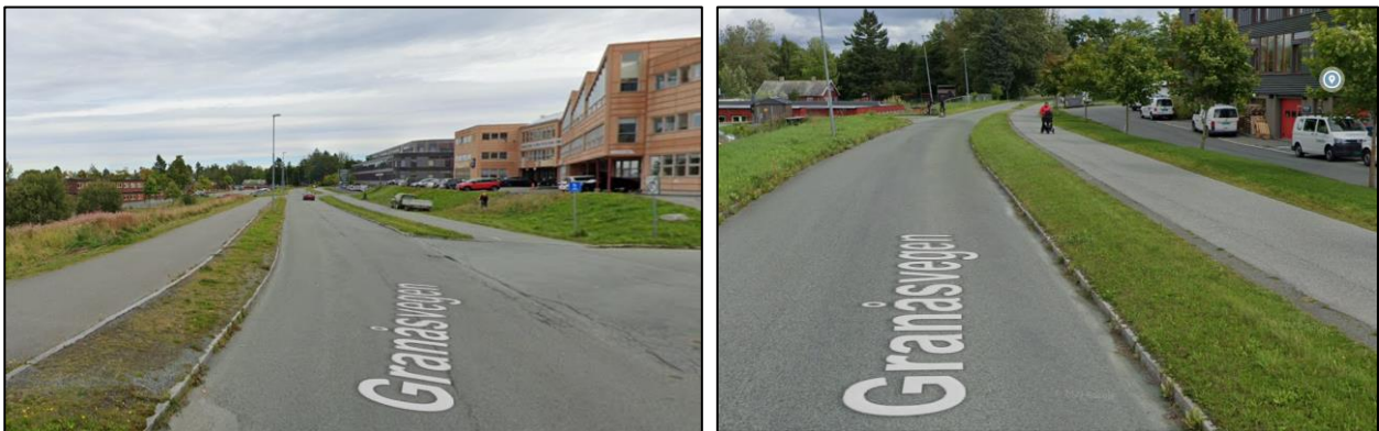
Figur 2-8: Brøsetekra har kombinert gang- og sykkelveg på begge sider, frem til skolen (venstre), deretter kun på sørsiden (høyre). Begge bilder sett i retning mot øst (Google Street View, august 2020).
