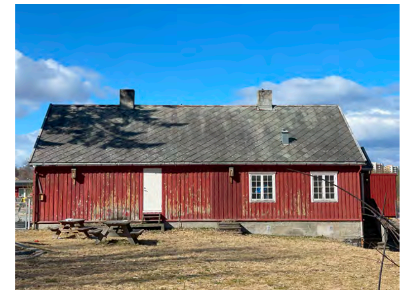
Bilde fra befaring, viser Orténbygget
