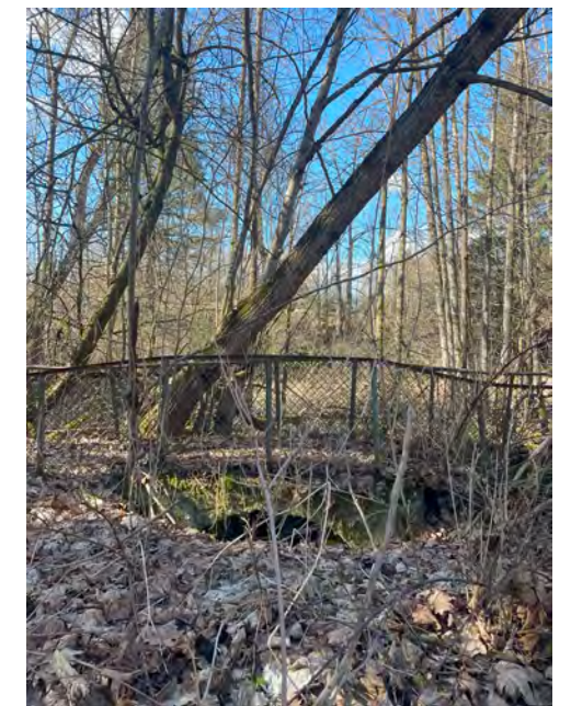
Bilde fra befaring, viser bro mellom Overlegebolig og Forvalterbolig.
