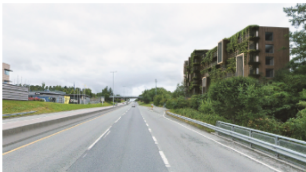
Støyskjermende boligbebyggelse sett fra E6
