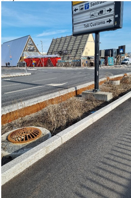
Figur 8 Eksempel på grøntribatt med sandfang langs veg.
