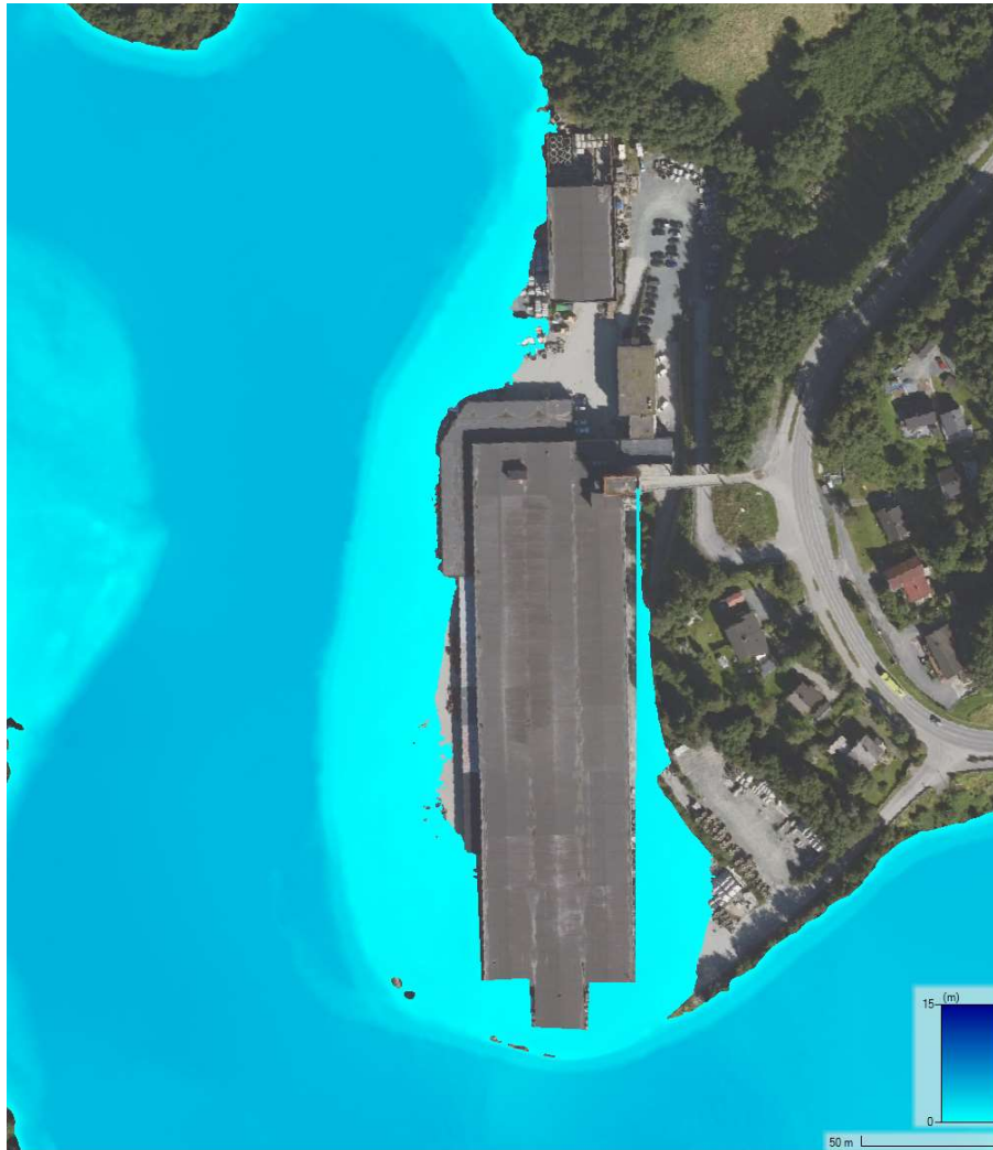
Figur 5-1: Flomsone for Leirfossvegen 71 ved 200-årsflom
