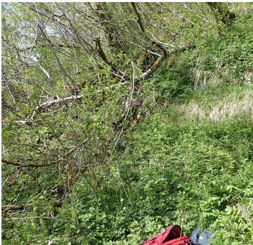
Figur 18: Sig i skråningene ved Storvollen. Mye leir i løsmassene her.
