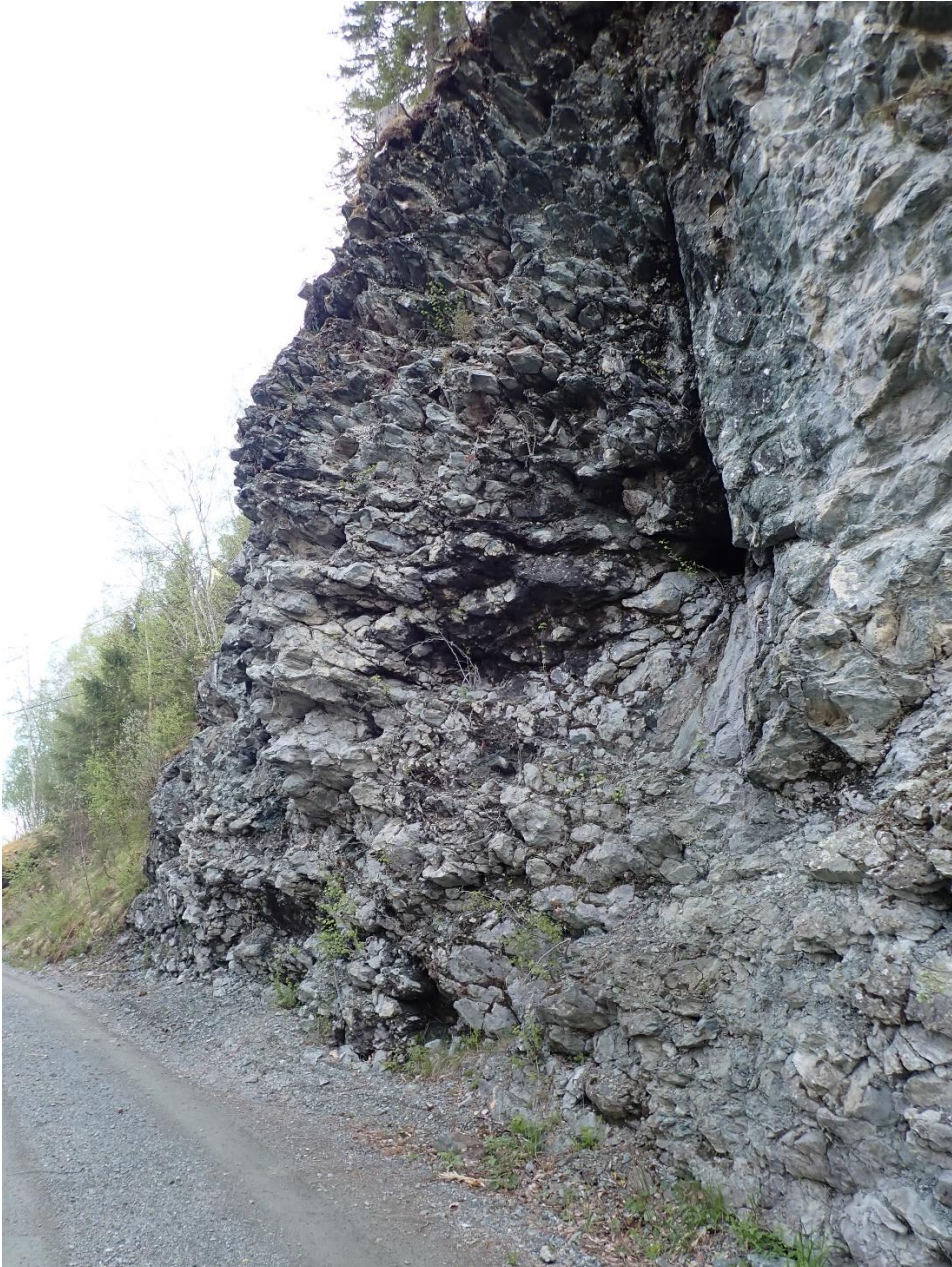
Figur 11: Bergmassen viser en tydelig knollete struktur som gir potensiale for smånedfall.
