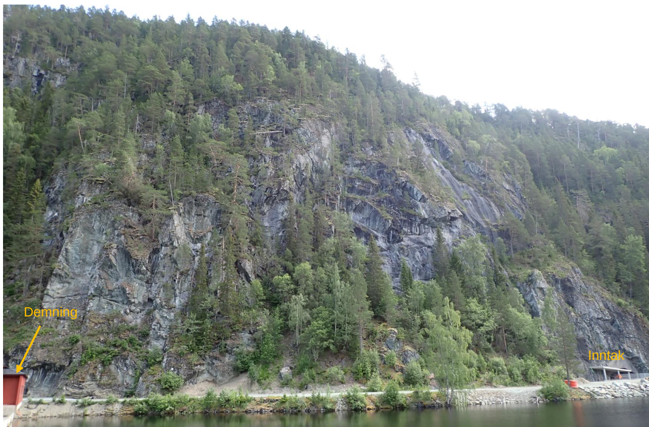
Figur 4: Bratt parti mellom demning og inntak der Statkraft har utført omfattende sikringstiltak.
