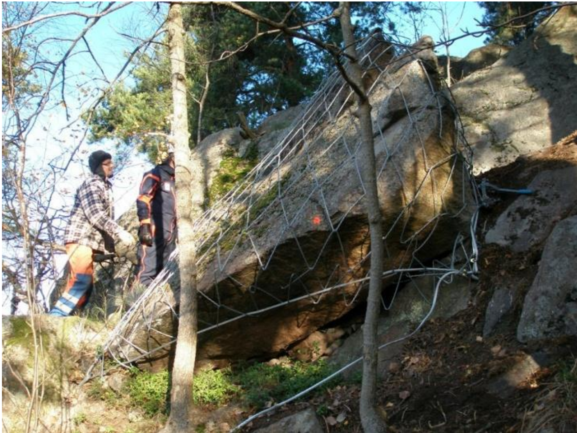
Figur 9. Eksempel på bruk av wirenett/stålringnett. Foto: K. Moen, Multiconsult AS
