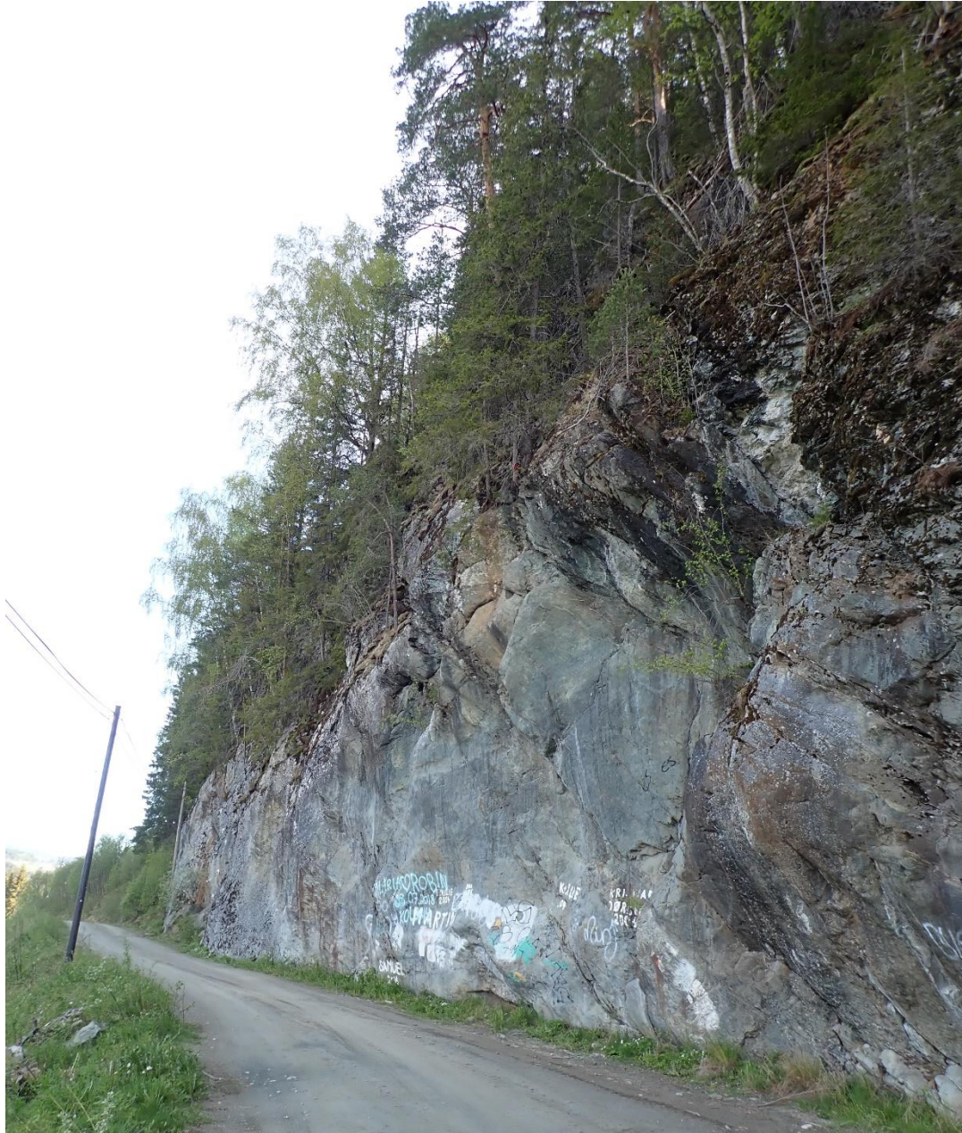
Figur 13: Nordlig del av skjæringen ved lokalitet 3 er mer massiv og har mindre potensiale for nedfall ved rot-/frostsprenning.
