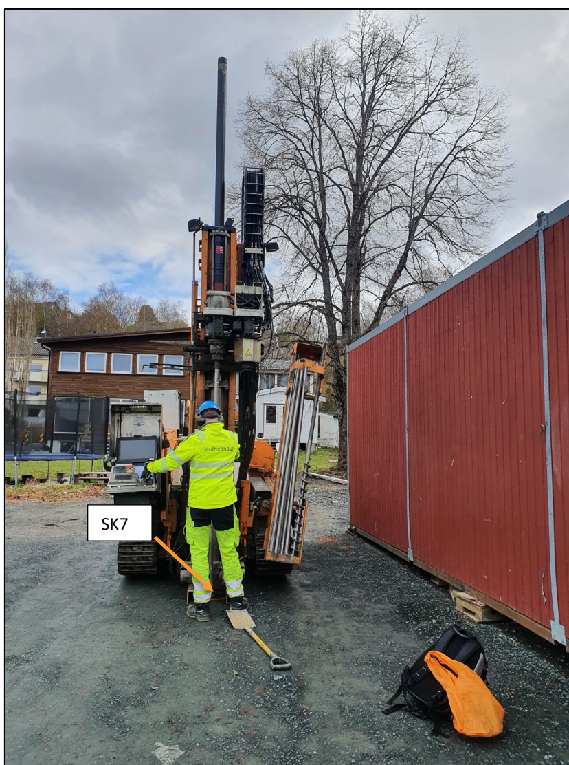
Figur 15: Plassering av borpunkt SK7, ved tidligere plassering av kranfundament. Foto: Multiconsult.
