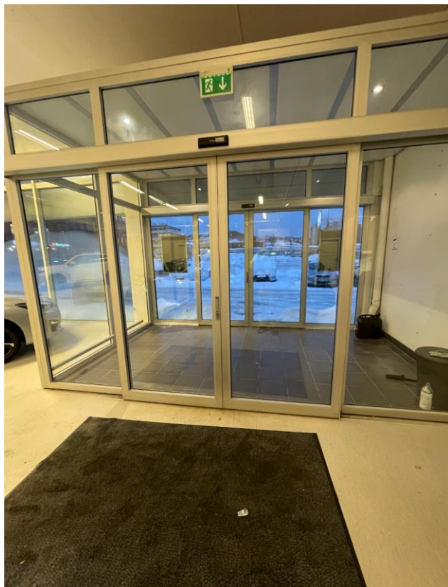
Figur 9: Vinduer og dører i forholdsvis god stand ved inngangsparti til bruktbilforretning.
