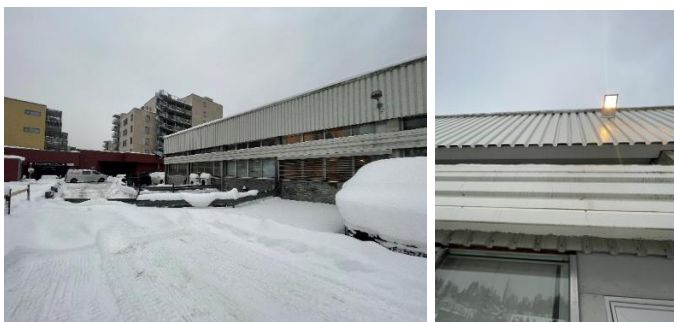
Figur 10: Korrugerte stålblater langs fasade.
