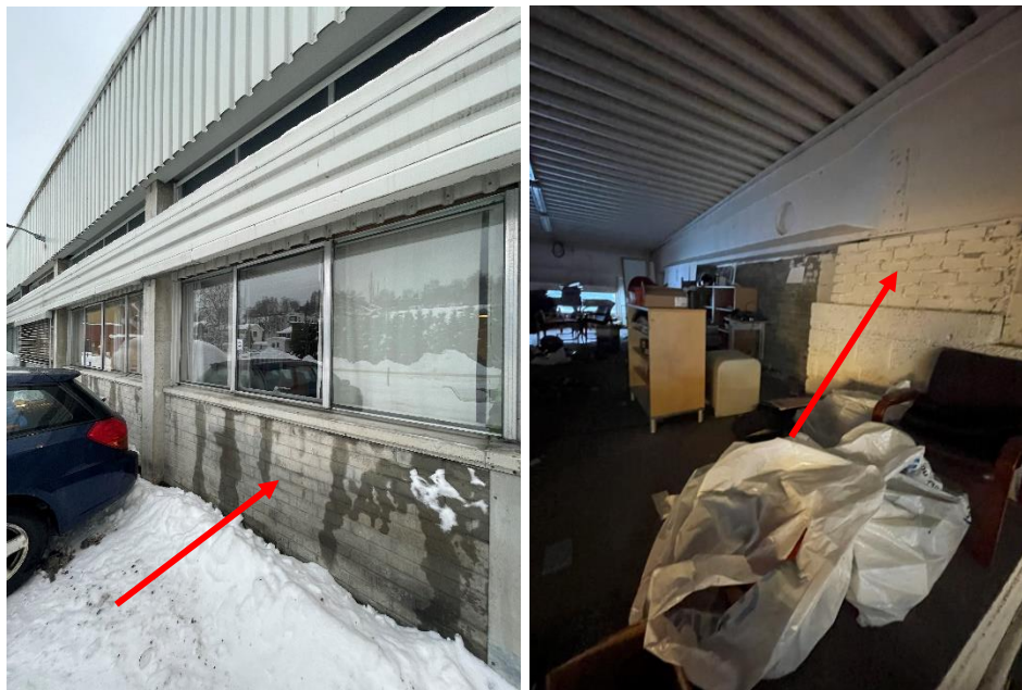
Figur 8: Murstein av betong langs nedre deler av fasade og teglstein over mesanin i nordlig påbygg.
