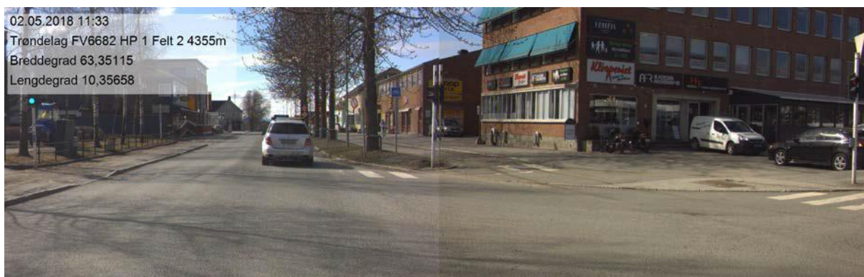
Bilde fra krysset mellom Heimdalsvegen og Ringvålvegen. Heimdalsvegen har i dag to felt. Bildet er fra mai 2018 (Kilde: SVV)
