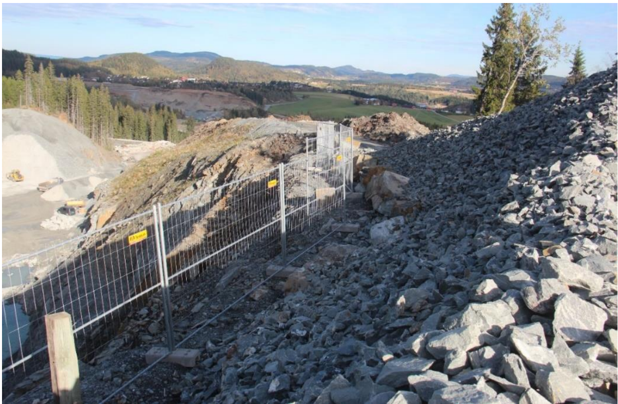
Sikring med gjerder rundt aktivt brudd
