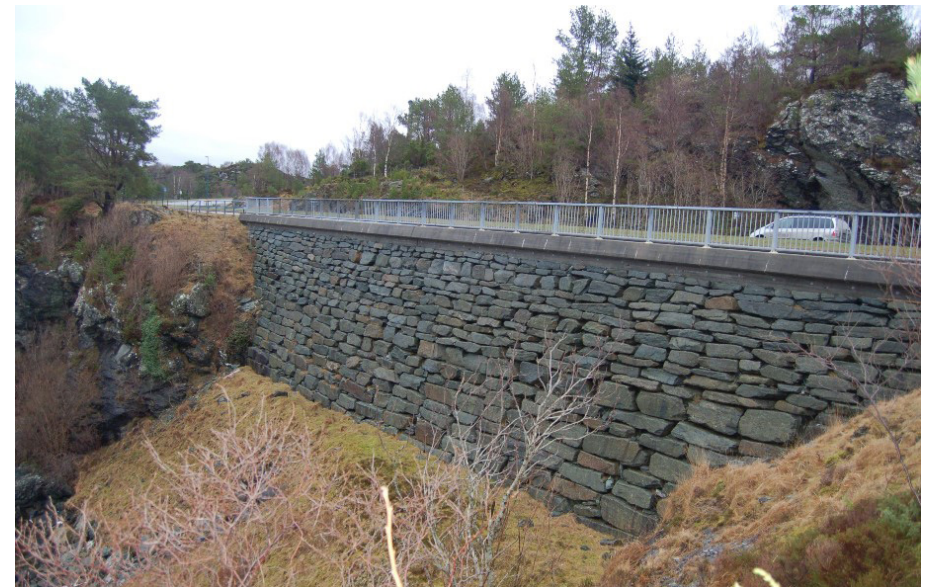
Støttemurer kan utformes på mange måter. Valg av riktig type støttemur til det konkrete landskapet veien beveger seg igjennom vil være avgjørende for anlegget. Bildet over viser en støttemur i naturstein. Bildet er hentet fra nettsiden til Karmøy naturstein.
