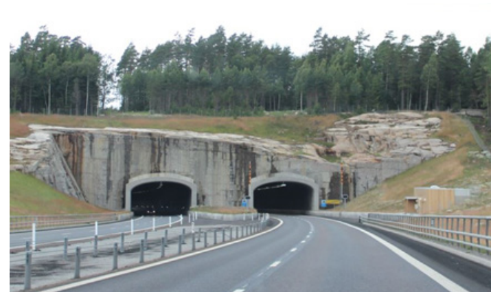
Bildet over viser eksempel på et teknisk bygg langs E6 ved Tanum. Bygget er kledd med tre (eik) som gjør at bygget glir godt inn i veiens sideterreng i tillegg til at det er plassert i en nisje og synes derfor nesten ikke, men opprettholder likevel etterspurt funksjonalitet. Foto: Katharina Nyström
