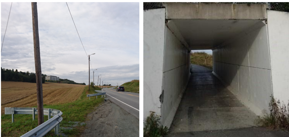
Lysmaster langs fylkesvegen ned mot Reppesbekken og kulvert under fv. uten belysning.
