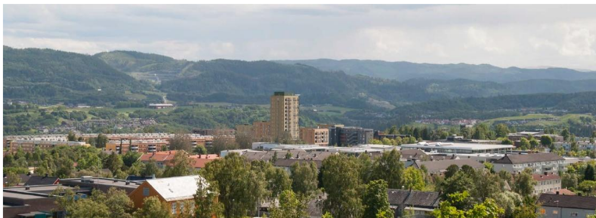
Fig. 14: Fjernvirkning fra Ferstad
