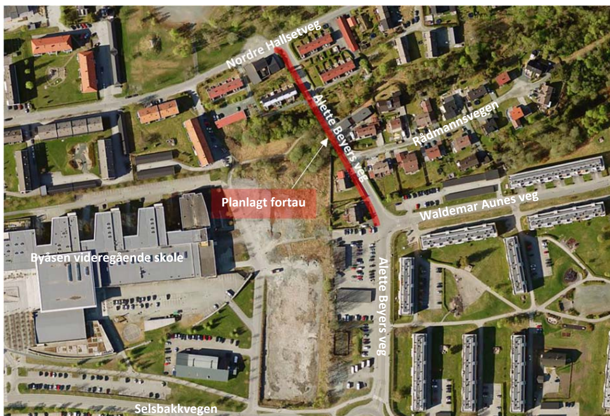
Figur 3-1 Flyfoto over Alette Beyers veg med Selsbakkvegen mot sør og Nordre Hallsetveg mot nord (kilde: kart.gulesider.no)
