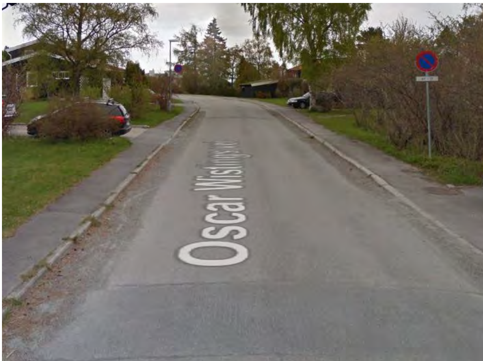
Figur 18 Oscar Wistings vei uten fortau (over) og med tosidig fortau (under)
