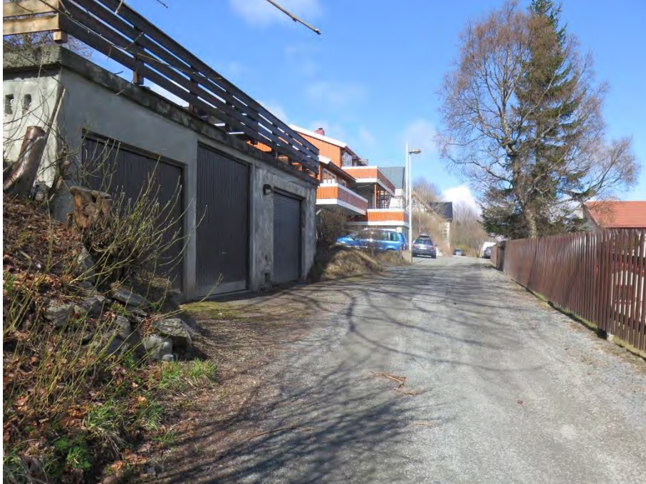
Figur 5 Sverre Hassels vei sett fra Byåsveien, april 2017
