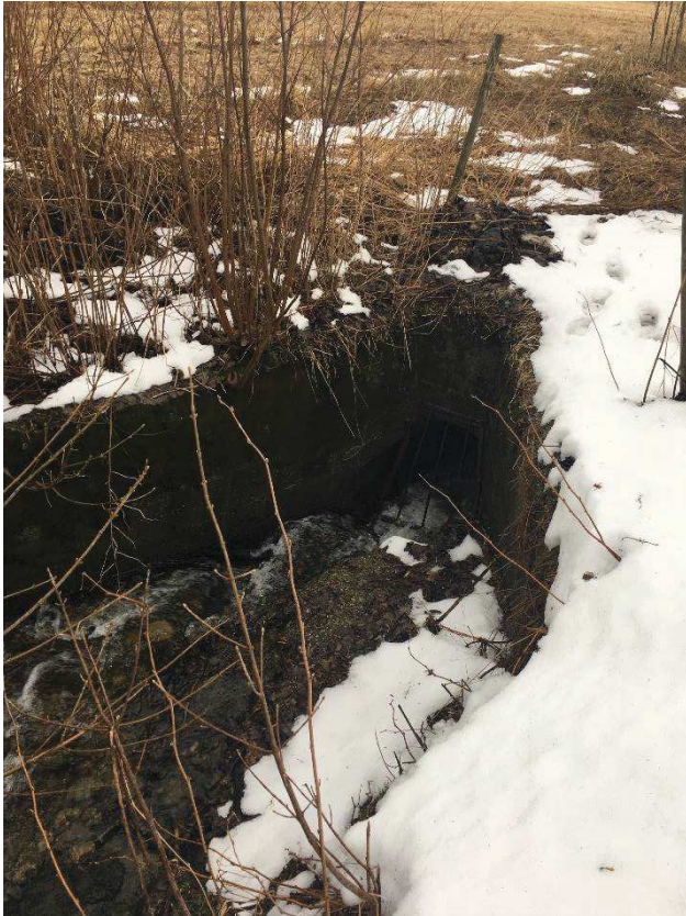
Bilde 2. Innløp Ø800 mm bekkelukking
