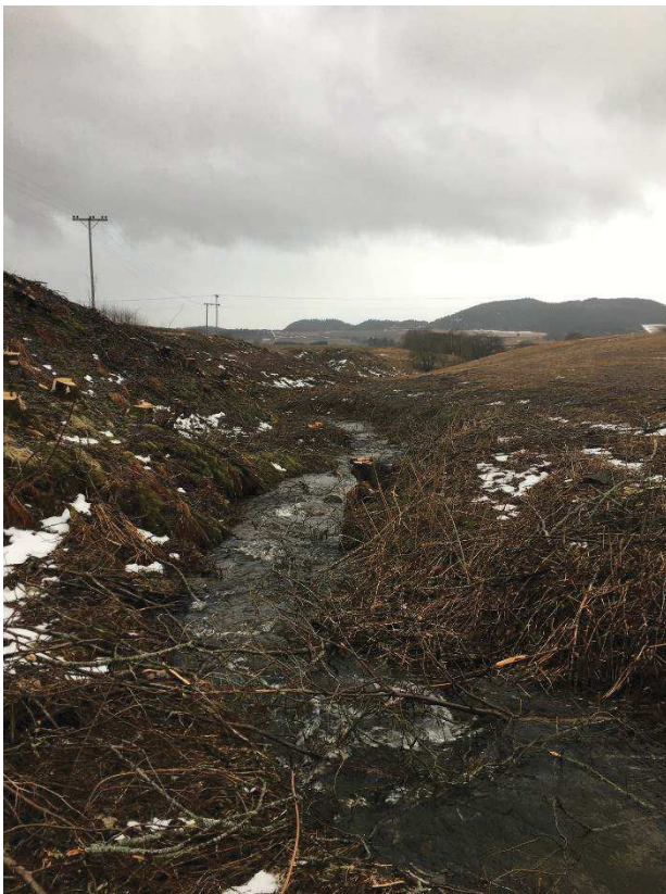
Bilde 5. Hafellbekken, rett nedstrøms stikkrenneutløp
