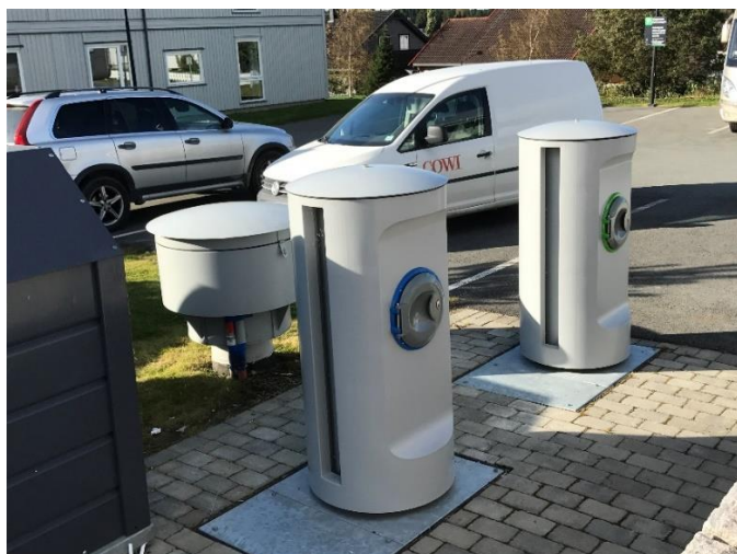
Eksempel på AFS-nedkast med tilluftsventil på Tiller Øst (Foto: Aage Heie)
