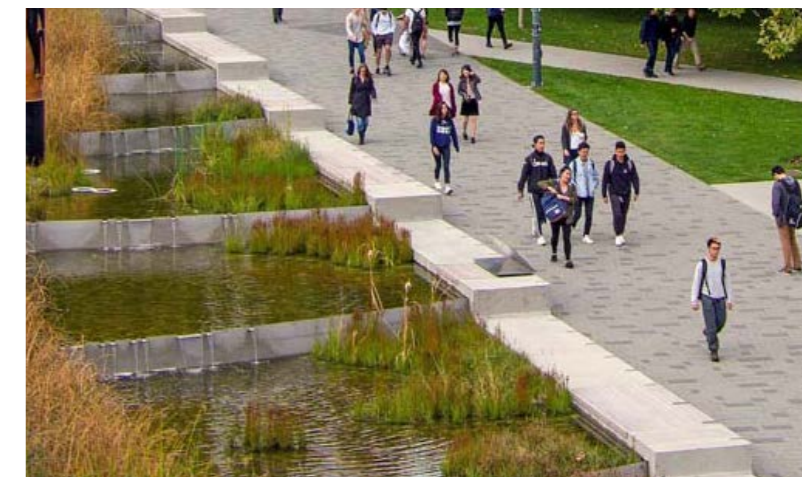
Vegetasjonen har en viktig rolle i fordrøyning av overflatevann og vegetasjonsfeltene må derfor planlegges detaljert med tanke på å tåle fuktighet
