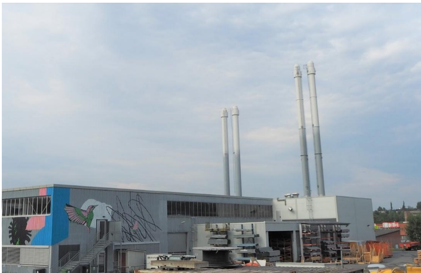
Figur 13 Pipene til varmesentralen i Leirfossvegen
