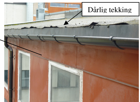
Platekledning av tynne stålplater.
