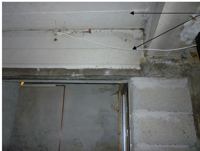
Støpte betongdragere og dekke
