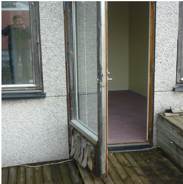
Dør og vinduer mot takterrasse.
