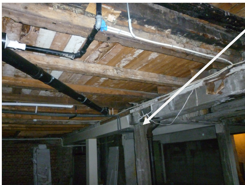
Bjelkelag og stubb-golv under bakgård vest.
