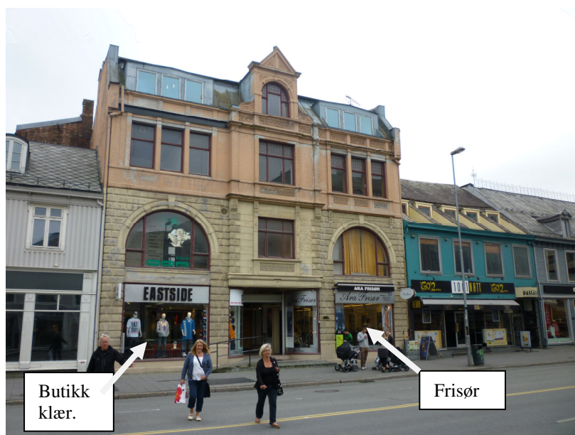
Fasade mot Olav Trygvassonsgate,.
