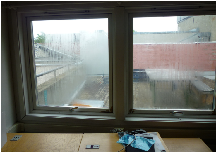
Vindu mot takterrasse.
