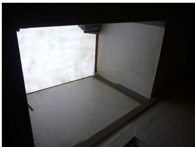
Overlyskuppel, mot takterrasse.
