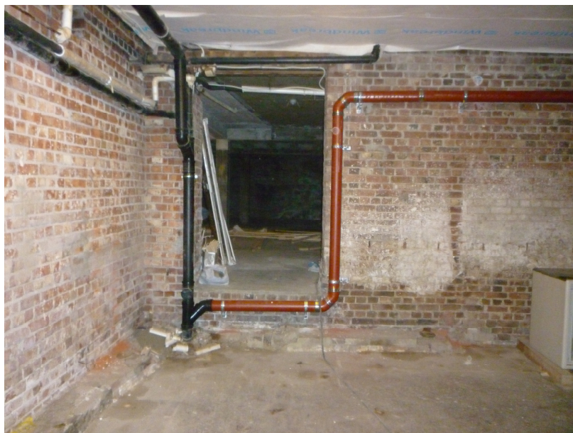
Bilde tatt fra laveste kjellernivå mot bakgård.
