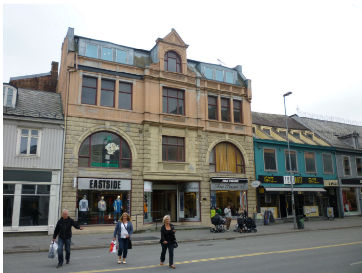
Fasade mot Olav Trygvassonsgate.
