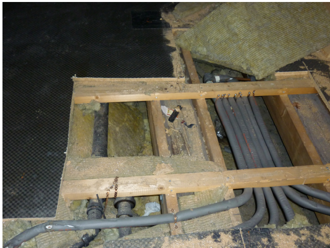
Viser oppforet golv, og føringer med vannrør.
