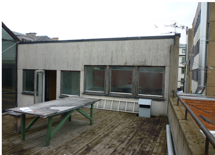
Fra terrasse plan 3. Betong veggelementer.
