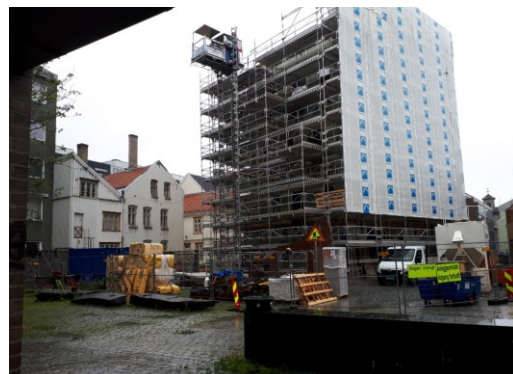
Peter Egges plass, sett fra inngang (stillasene antyder ikke etasjedeling) Deler av bygningen er opp mot cote +29
