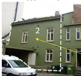
Olav Tryggvasons gate 17
