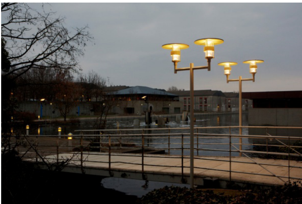
LED-versjon av Albertslund-lykten, med god lysfordeling og høy visuell komfort uten direkte innsyn til lyskilden
