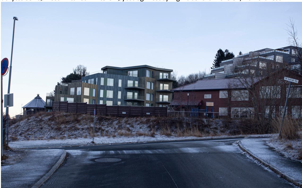
Tiltaket sett fra Jonsvannsveien med Bergheimsvegen 28 i bakkant og barnehagen til høyre.
