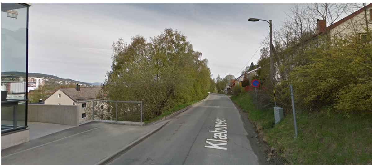
Figur 5 I dag avsluttes fortau brått ved Øystein Møylas veg 14, 16 og 18
