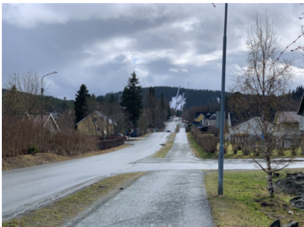
Eksisterende situasjon med gang- og sykkelvei langs vestsiden av Nils Uhlin Hansens veg
