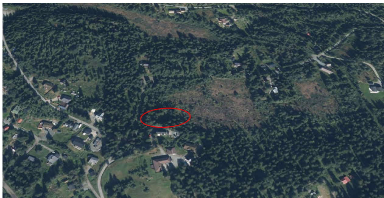
Skråstilt flyfoto mot nord/nordvest (Norge i bilder). Eiendommen med rød ring.
