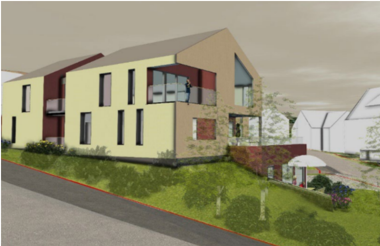
Figur 7 Terrenget går opp til underkant av gulv i 1. etasje i minimum halve bredden på gavleveggen mot øst på bygg A
