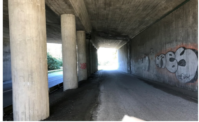
Eksisterende undergang under E6. Gang-/sykkelvegen har en bredde på 4,6 m.
