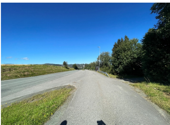
Dagens gang- og sykkelveg sett mot nord. Okstad holdeplass nordgående retning til høyre i bildet.
