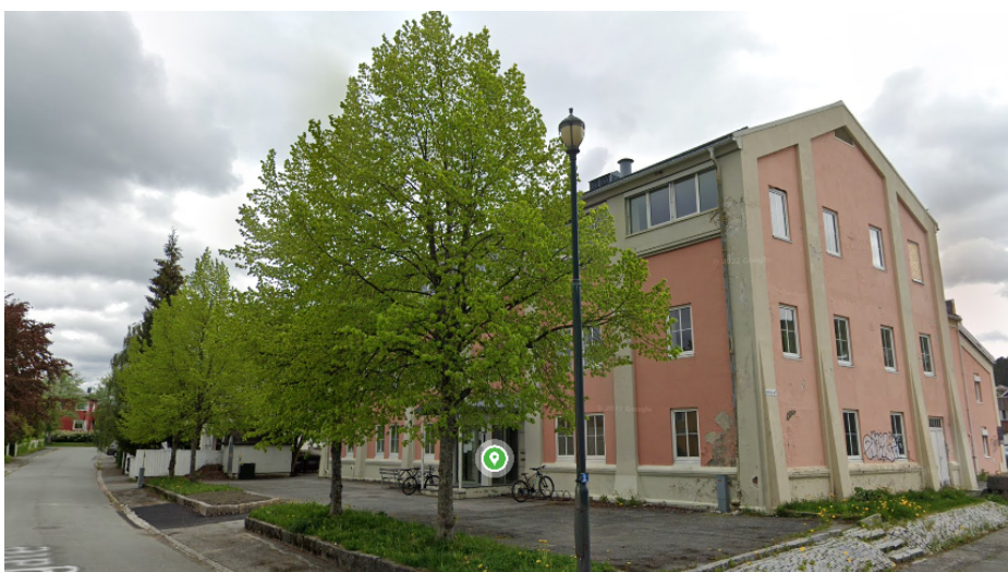
Foto av eksisterende situasjon viser trerekke i Guttorms gate som skal bevares.
