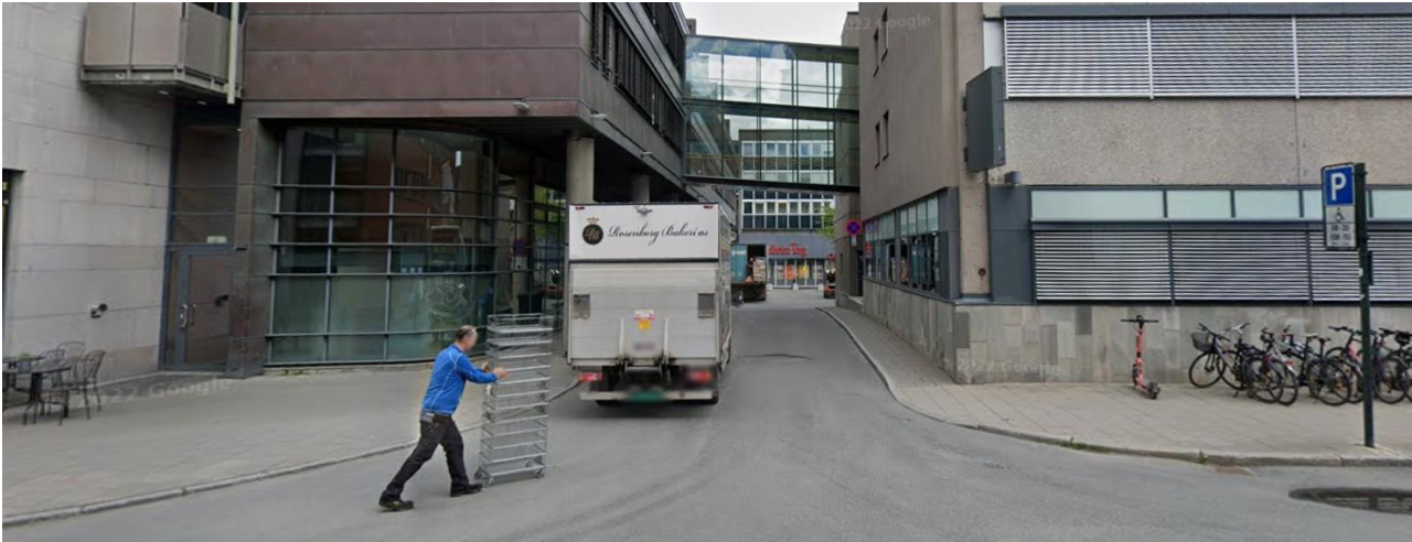
Tinghusplassen sett fra Erling Skakkes gate: Dårlig tilrettelegging for myke trafikanter, uten overgangsfelt og med kantareal som kan misoppfattes som fortau.
