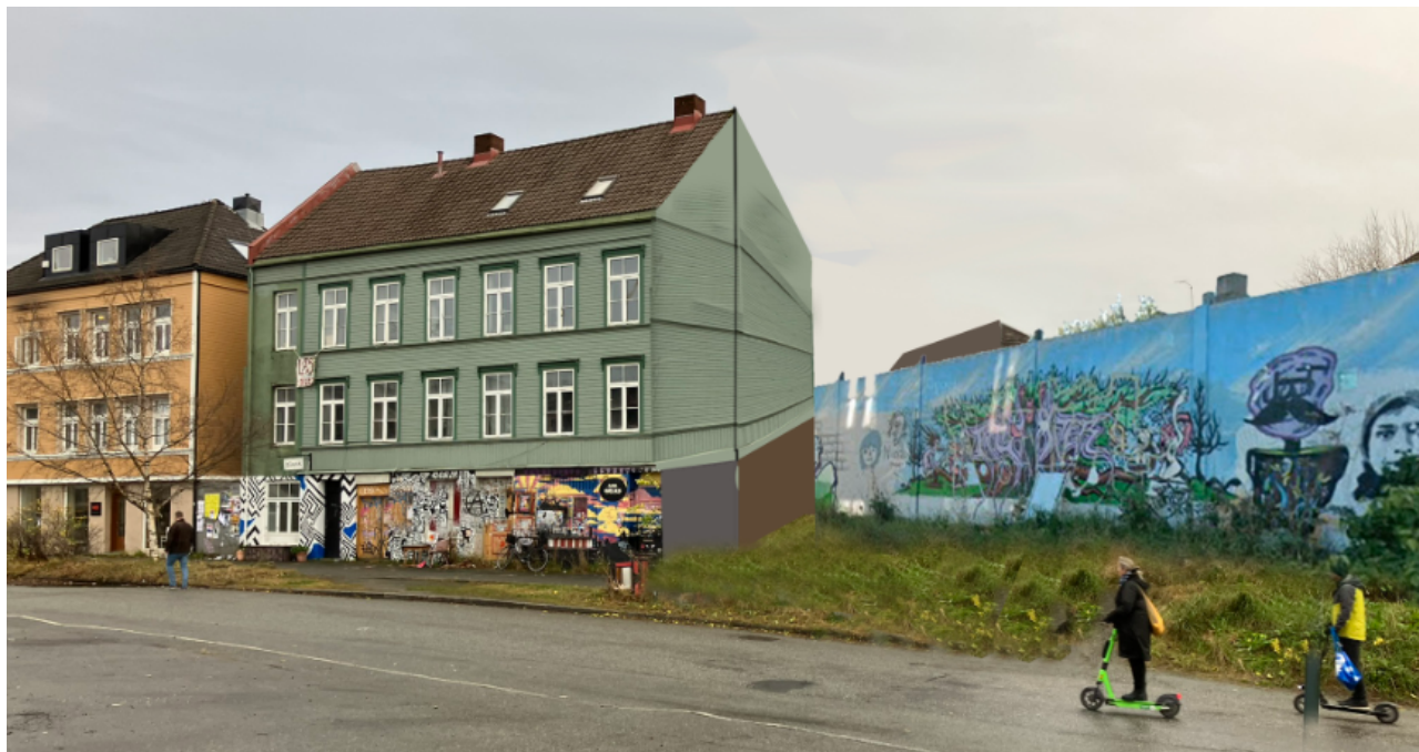
Illustrasjonen viser at bygningen i Strandveien 23 kan bli seende slik ut etter at del 5 er bevart og del 3 er ferdig gjenoppbygd.
