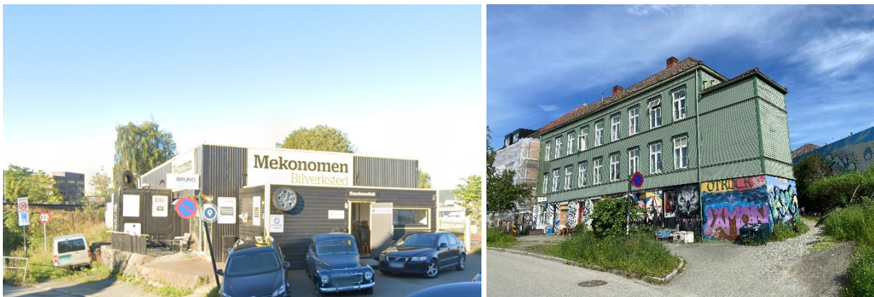
Til venstre: Mekonomen/Strandveien 44 før den ble revet. Til høyre: Strandveien 23. Foto: Rambøll
