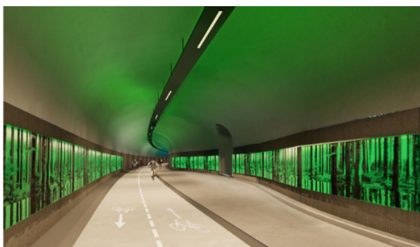
Eksempel på bruk av kunstbelysning i den nye sykkel tunnelen til Fyllingsdalen i Bergen.
